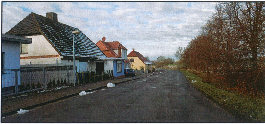
Geltungsbereich 2 – einreihige Bebauung an K 21 – Blick in Nord-Ostrichtung
