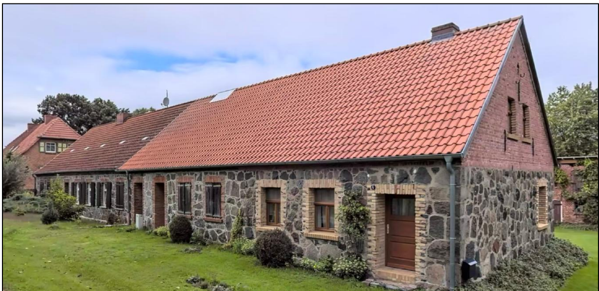
Abbildung 10 Landarbeiterhaus Kyritz - Quelle: Google Street View
