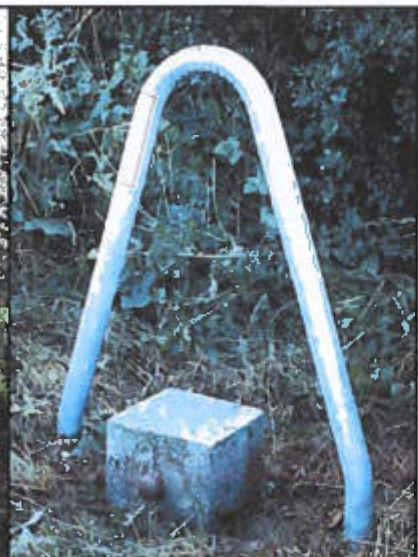
HFP Granitpfähler 25 cm x 25 cm mit seitlichem Bolzen und Stahlschutzbügel
