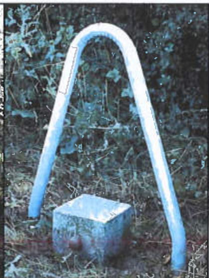
HFP Granitpfeller 25 cm x 25 cm mit seitlichem Bolzen und Stahlschutzbügel
