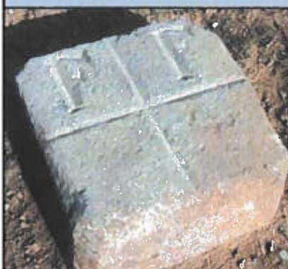
TP (Meckl.) Steinpfeller bis 35 cm x 35 cm (auch mit Keramikbolzen)*
