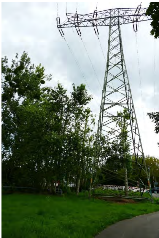
Bild 18 Freileitung im SO
