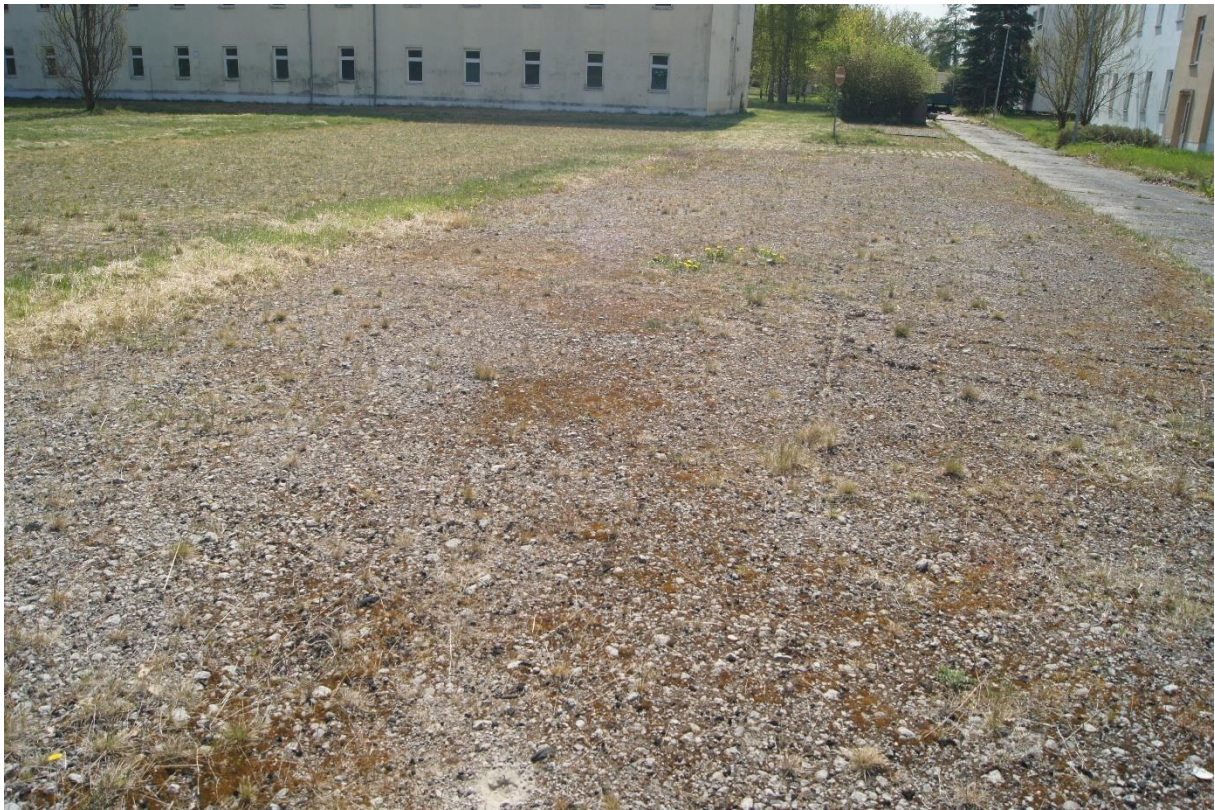
Bild 51 Teilversiegelung mit Spontanvegetation (PEU) östlich Gebäude 17
