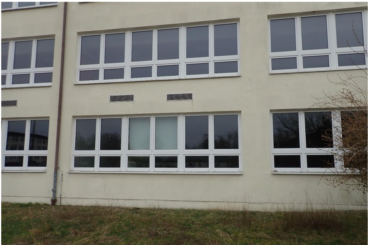
Bild 63 Lüftungslammellen an mehreren Gebäuden vorhanden, hier Gebäude 12
