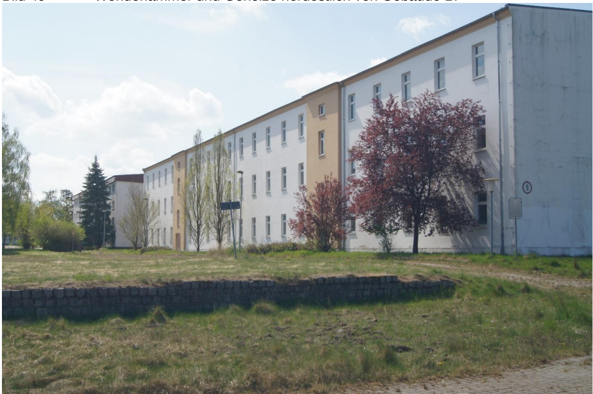
Bild 50 Gebäude 17, Gehölze und Mauer zum Ausgleich des Höhenunterschieds
