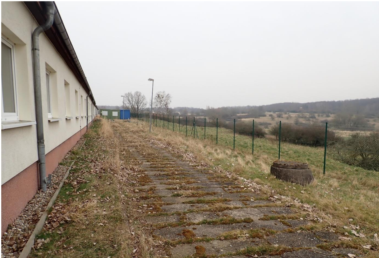
Bild 36 Östliche Grenze, Gebäude 11, im Hintergrund Lagerung von Containern
