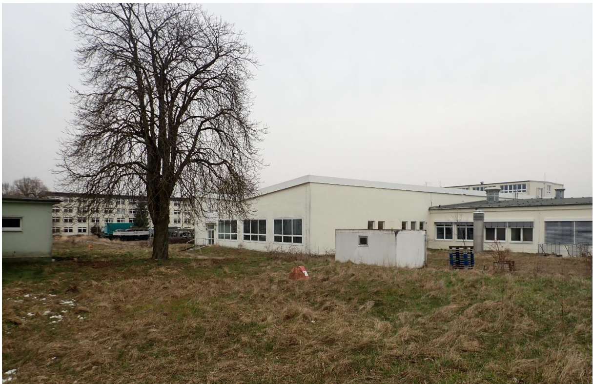
Bild 31 Gebäude 8, im Hintergrund Gebäude 13, links im Bild Gebäude 7
