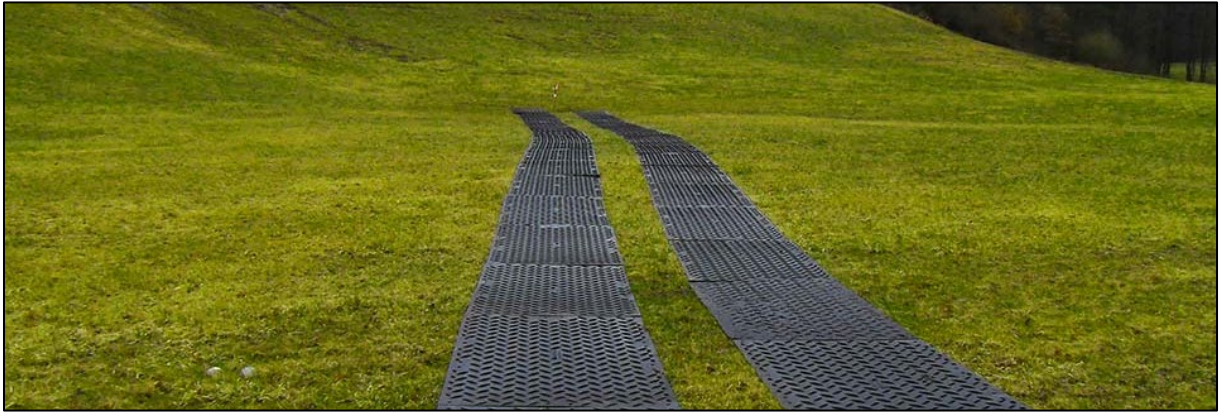
Abbildung 8: Beispielfoto mobile Baustraße zur Vermeidung von Bodenverdichtung ( https://www.securatek.de/Referenzen/s-tek-48-Hochleistungs-Bodenschutzplatte-als-Mobile-Baustrasse-beim-Rohrleitungsbau-bei-Creussen-in-Bayern )
