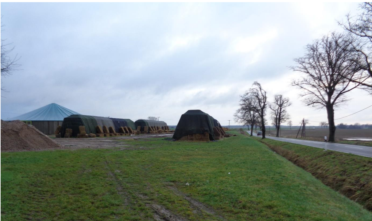
Bild 02 Plangebiet vom Westen
