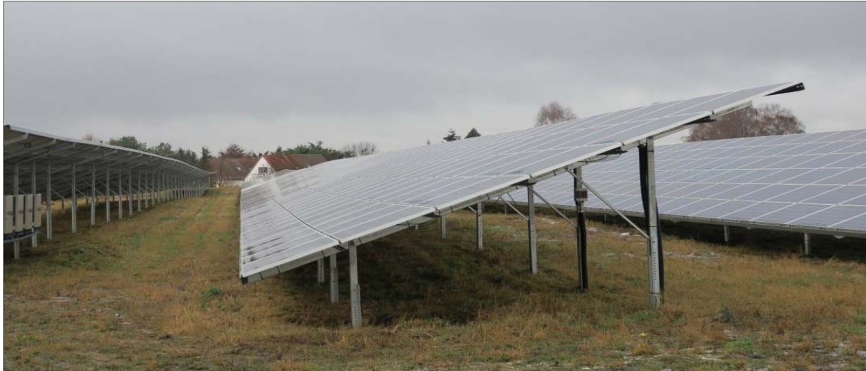
Abb. 1: Beispiel einer vergleichbaren PVA in Mecklenburg-Vorpommern
