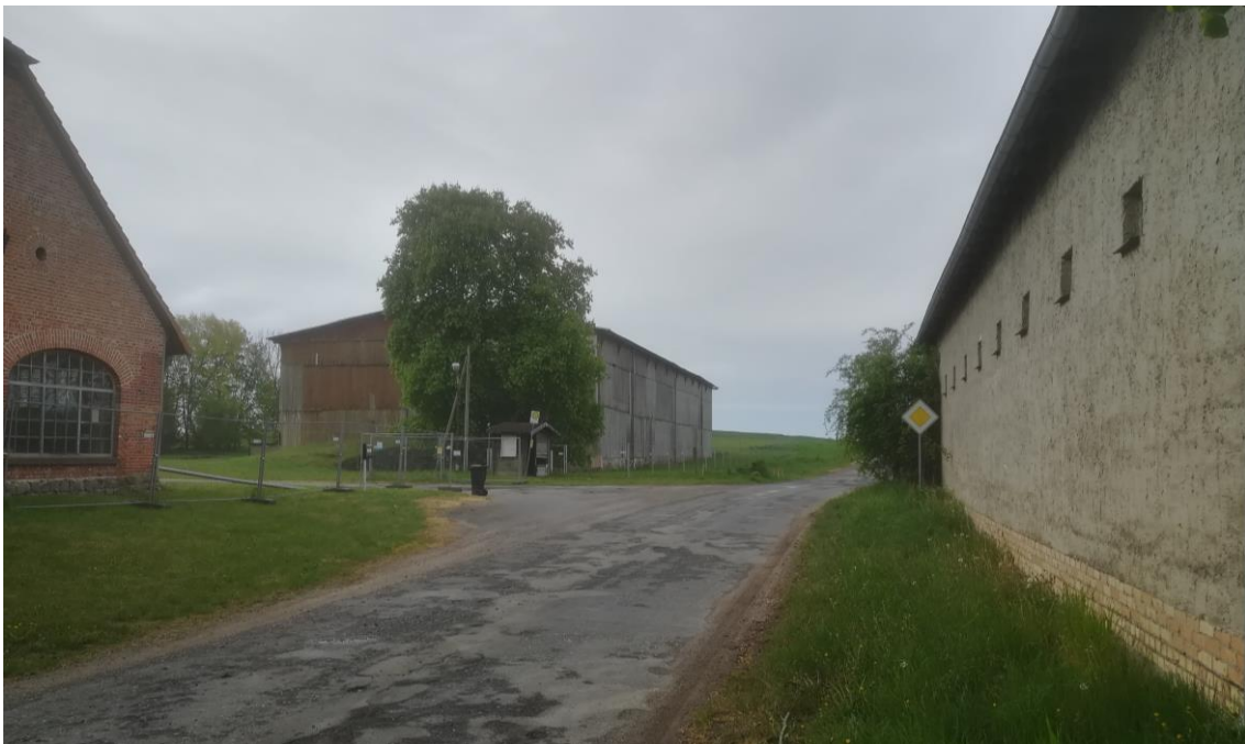
Abbildung 32: Blick auf den Eingangsbereich. Foto: Stadt Land Fluss 11.05.2022.
