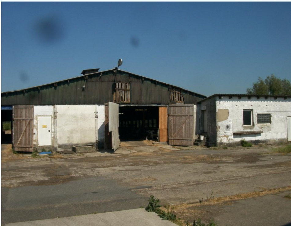
Bild 1.3 Südostgiebel, rechts Anbau
