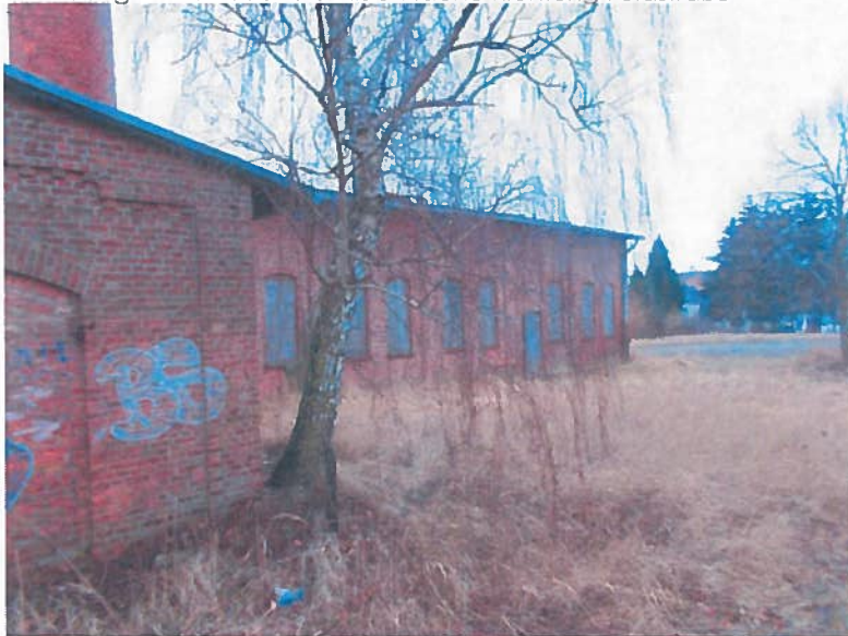
Abbildung 9: Restliche Gebäude auf ehemaliger Industriefläche
