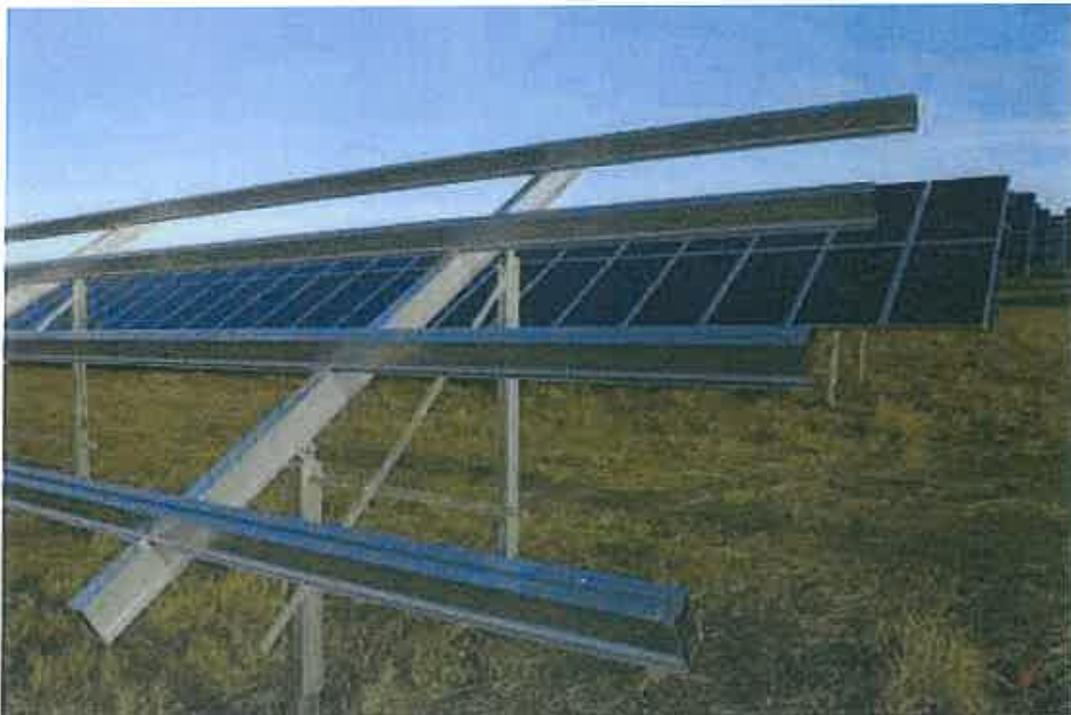
Abbildung 4: Systemdarstellung zur Aufständering der Gestelleinheiten. Quelle: SIG 2012.
