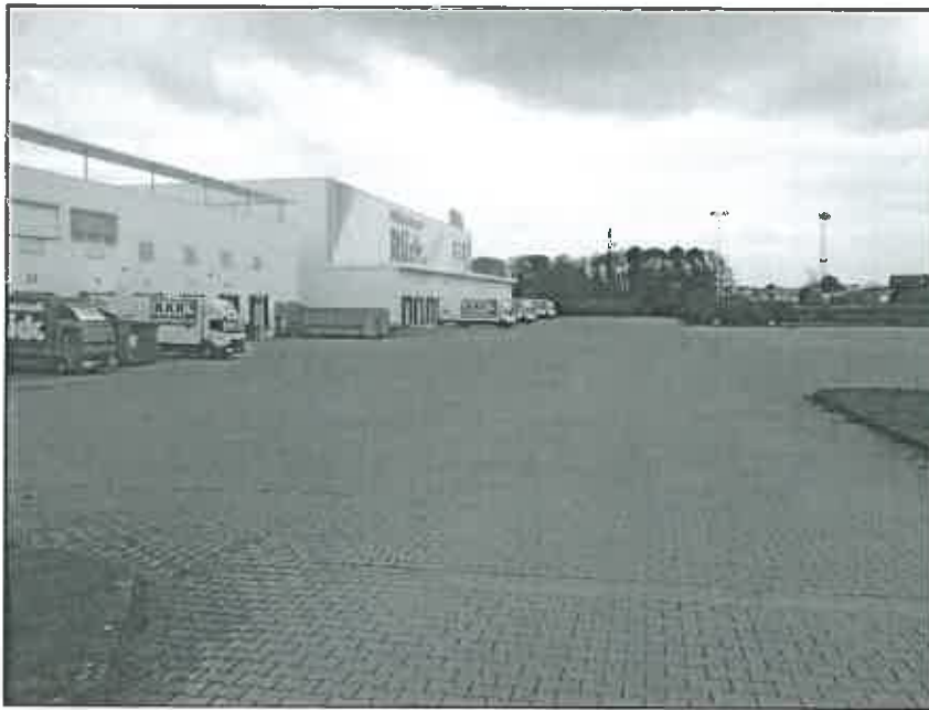
Abbildung 1: Möbeleinrichtungshaus mit versiegelten Flächen im Süden des Plangebietes (13.10.2016).
