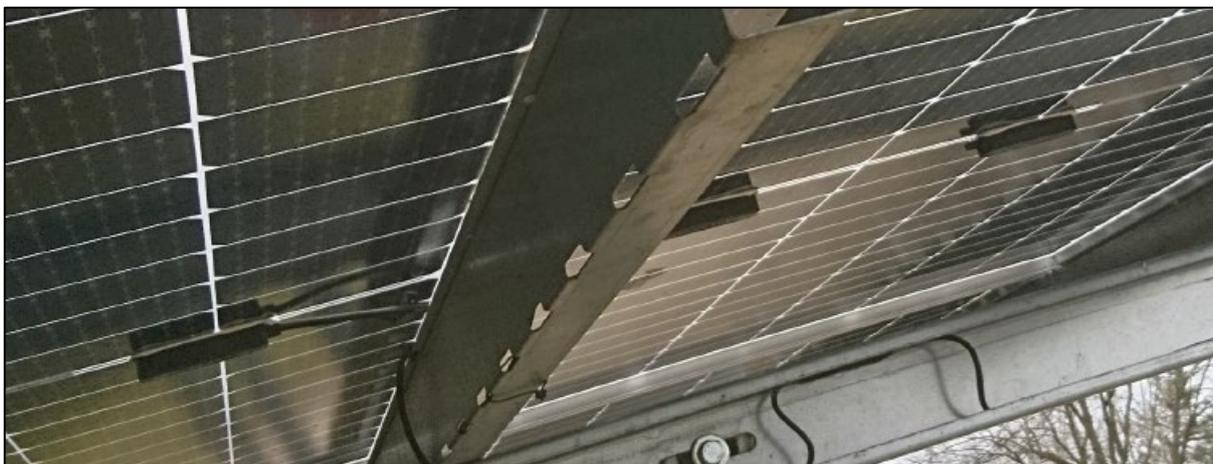
**Abbildung 4:** Beispiel eines SUNfarming Modultisches mit bifazialen Glas-Glas-Modulen und Regenwasserverteilschiene
