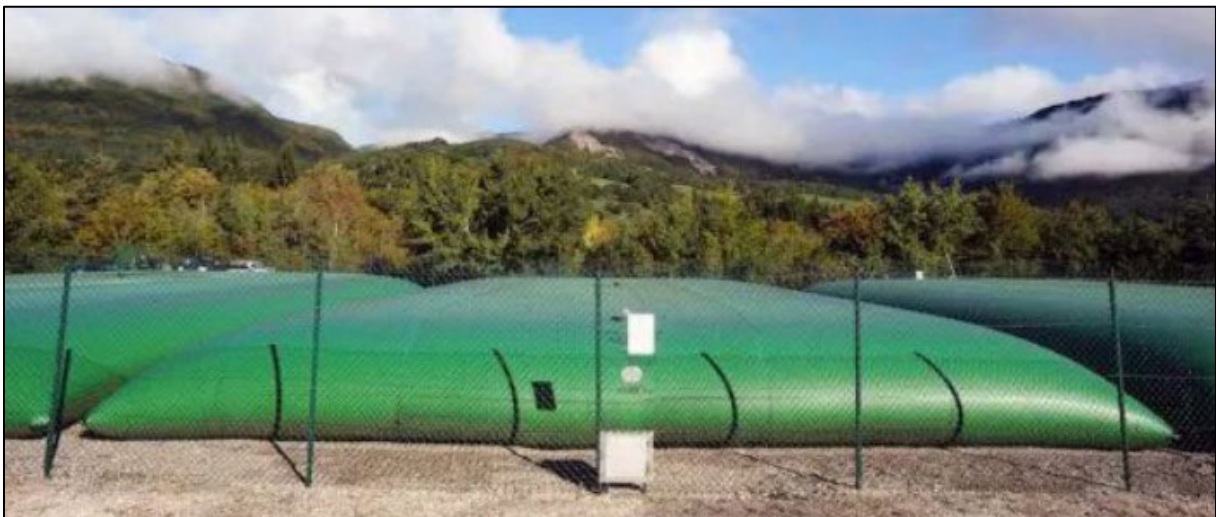
Abbildung 7: Beispiel Löschwasserkissen als faltbare Zisterne, Quelle: SUNfarming GmbH
