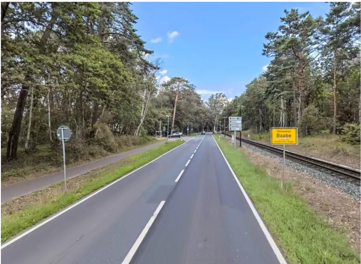
Abbildung 11: Blick in Richtung des Ortseinganges Baabe (B 196)
