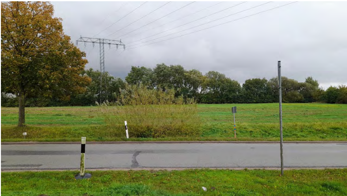
Abbildung 15: Blick auf die querende 110 kV-Freileitung. Foto: 10.10.2024.
