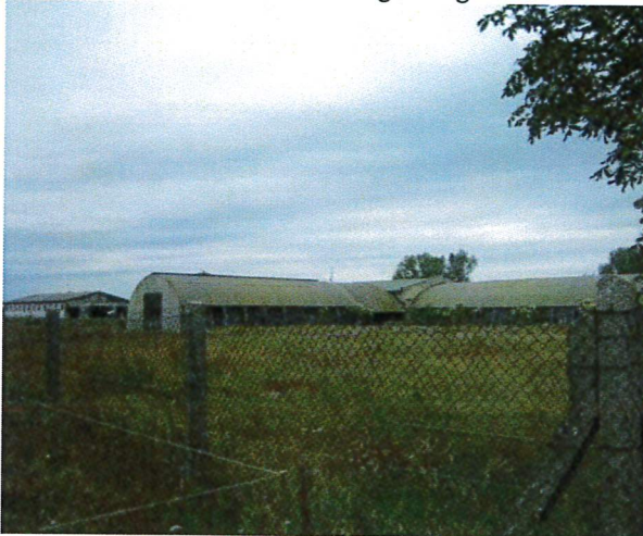
Bild 3 Tierproduktionsanlage vom Fahrradweg
