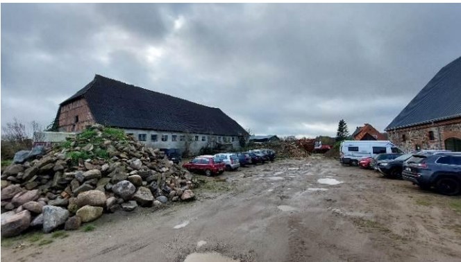
Platz zwischen sanierter und baufälliger Scheune
