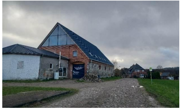
Saniertes Scheunengebäude des Textilbetriebes an der Dorfstraße
