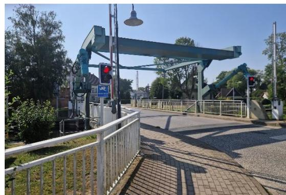
**Abb. 16: Klappbrücke über den Störkanal**
