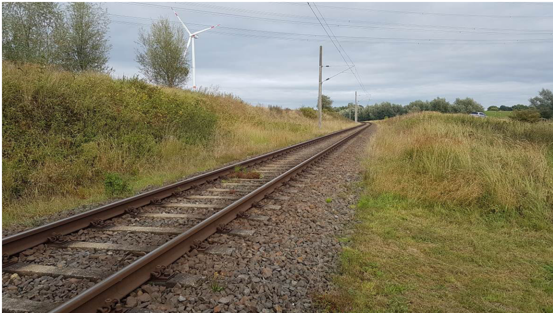
Foto 7: Bahnlinie südlich des Plangeltungsbereiches
