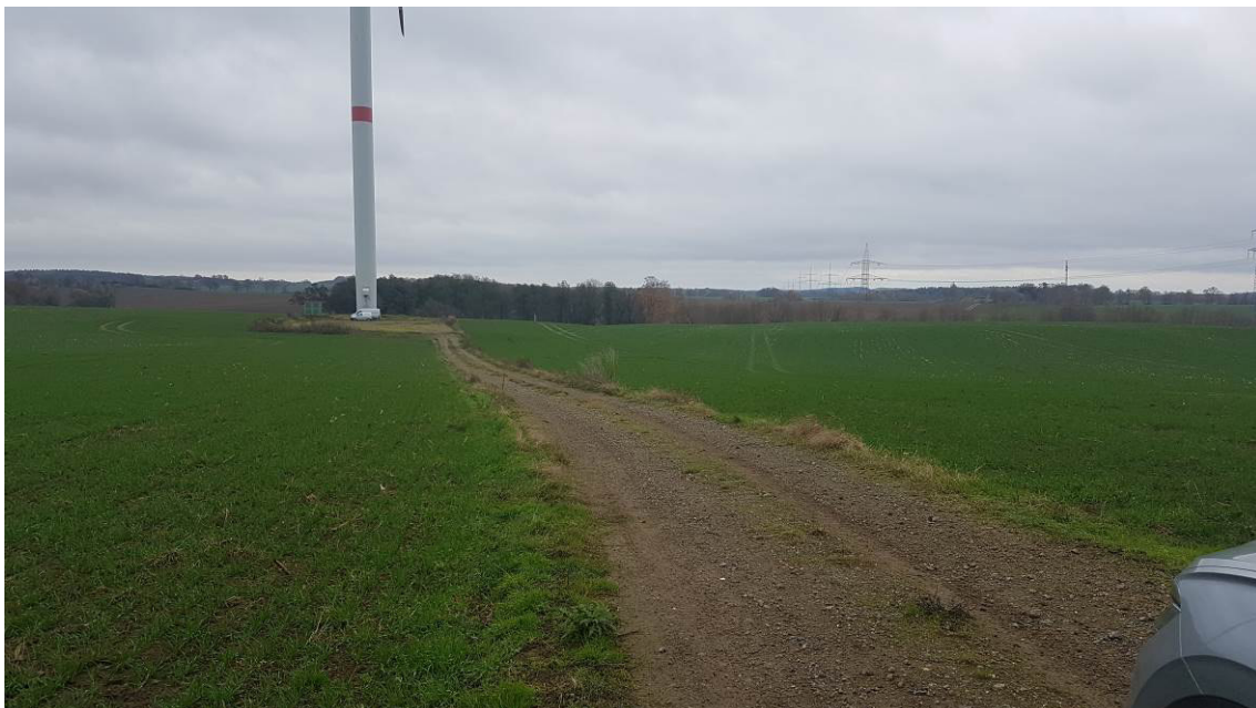
Foto 4: vorhandene Wegeflächen, welche gleichzeitig der Erschließung der Photovoltaikanlage dienen
