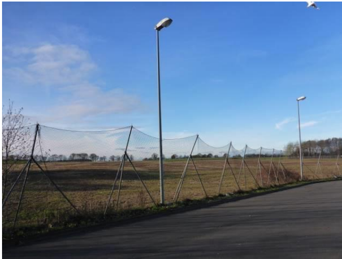
Abb. 11: Blick über die Fläche in Richtung Westen, eigene Aufnahme.
