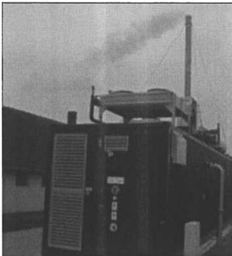
Bild 6: Ansicht eines BHKW – Containers Deutz TCG 2016B V12 der Fa. MWM
