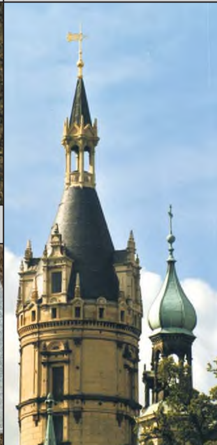
Hochpunkt (Turm Knopf u. a.)
