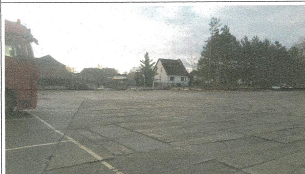
Abb.5. Versiegelte Fläche nach Nord- Ost aufgenommen.
